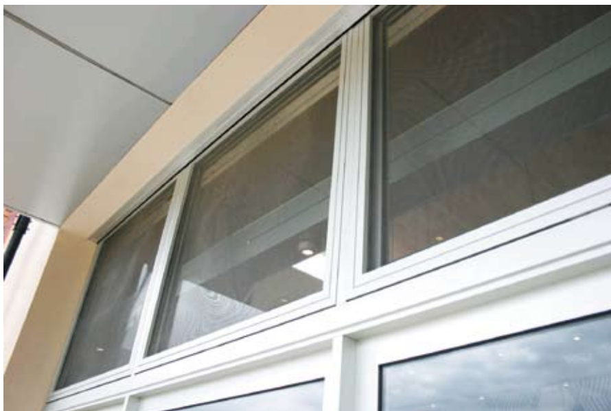
Película especial nos vidros combate a insolação, reduz o consumo de energia e proporciona conforto aos usuários
